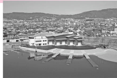
水上防災拠点施設・艇庫建設事業
